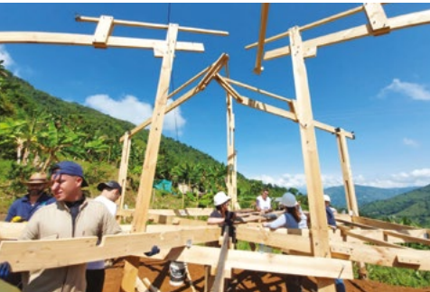
Figura 3. Proceso de construcción del módulo por estudiantes y docentes del programa de Arquitectura UCP (2021). Fuente: Intersemestral Taller de Construcción.
