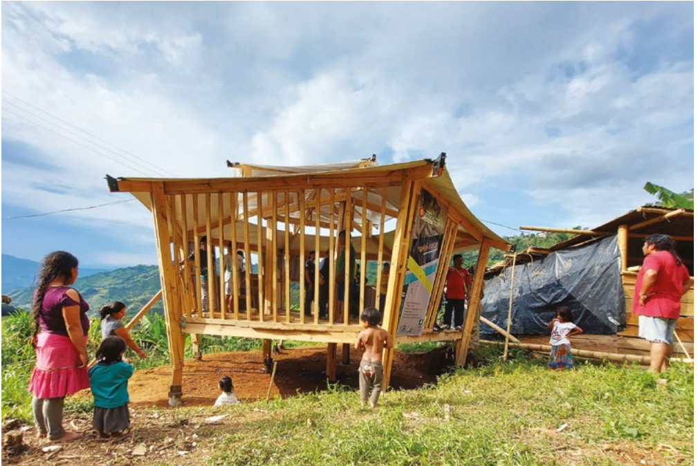
Figura 5. Wera Kíríca: módulo de articulación educativa. Obra arquitectónica (2021). Fuente: Intersemestral Taller de Construcción.
