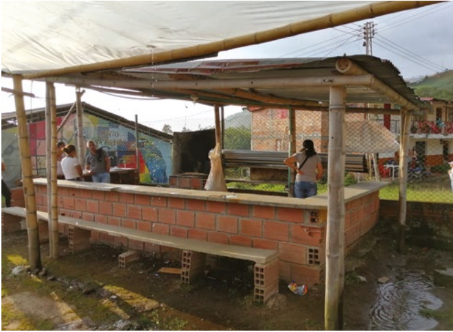
Figura 1. Estado actual de la cocina Santo Domingo. Fuente: propia.
