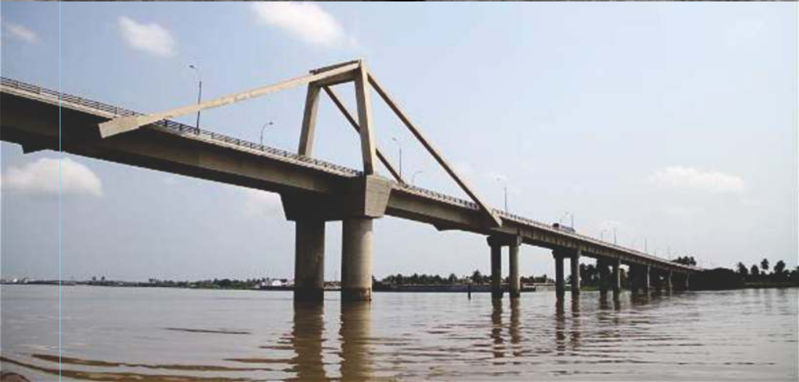
Camara de Comercio de Barranquilla (1974) Puente de Barranquilla llamado entonces Laureano Gómez, hoy puente Pumarejo. Ingeniero italiano Ricardo Morandi
