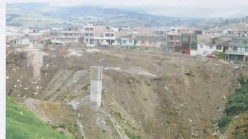
// Acumulación de escombros
