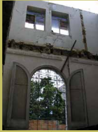
// Desarrollo de obra
