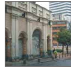
// Estado actual exterior
