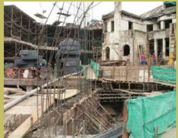
// Desarrollo de obra
