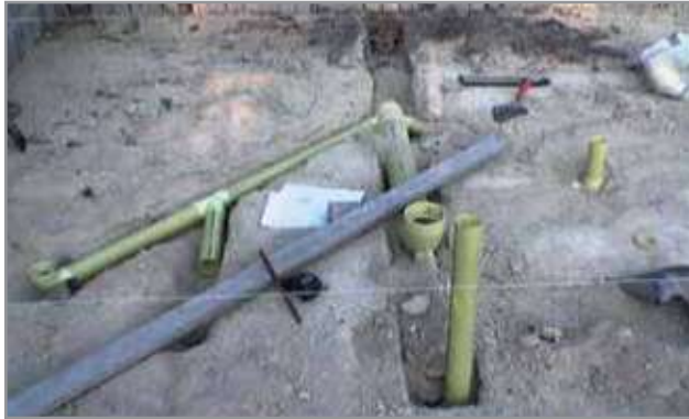
13 // Colocación instalaciones hidrosanitarias
