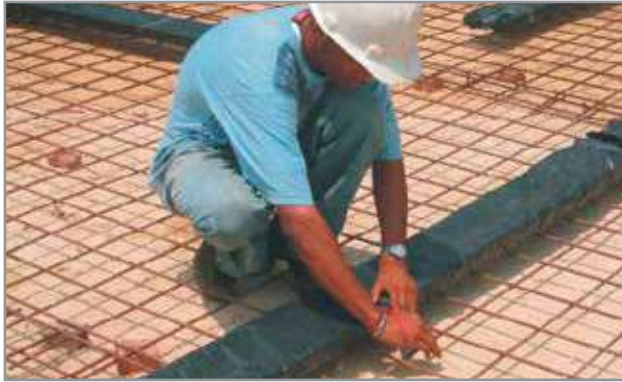
15 // Colocación de guías para las mallas
