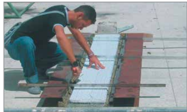
5 // Colocación de Icopor
