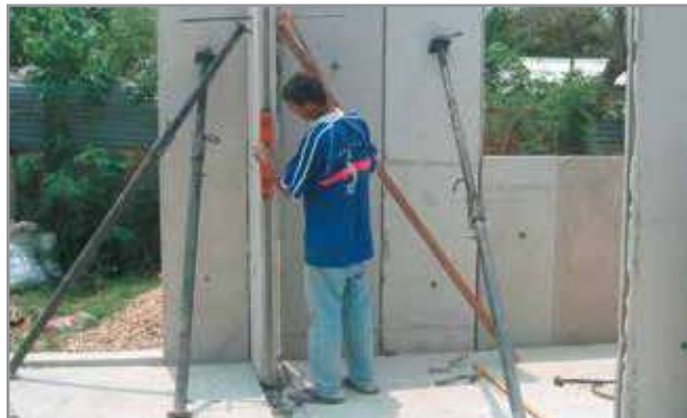
17 // Izaje de muros
