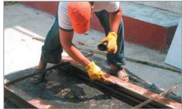
4 // Armada y aplicación de desmoldante
