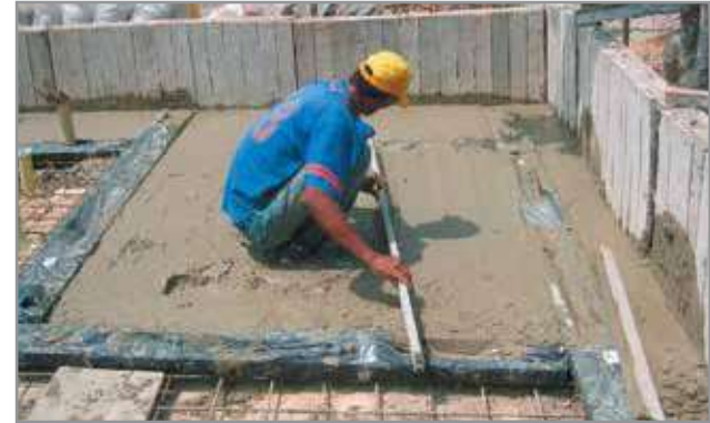
16 // Vaciado de la placa de cimentación
