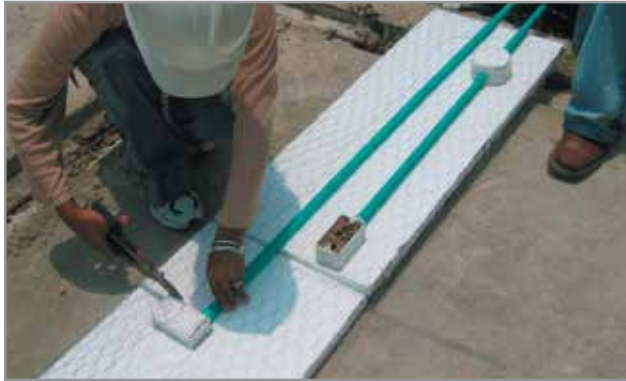
7 // Colocación de tuberías
