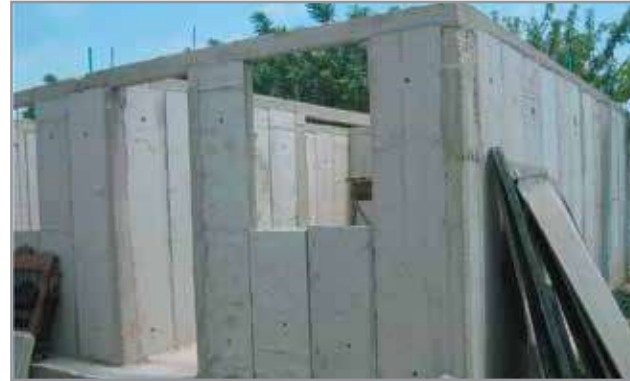
18 // Confinamiento de muros
