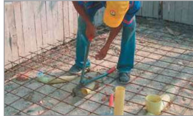
14 // Colocación Malla electro soldada
