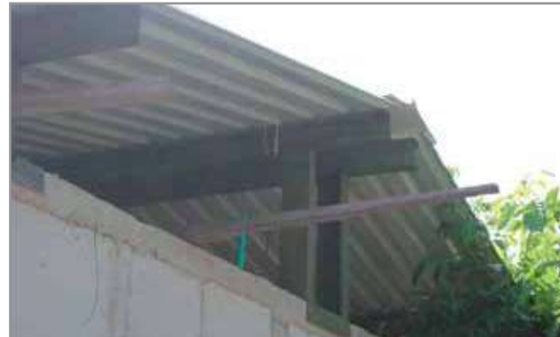
19 // Colocación de la cubierta
