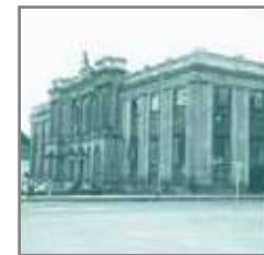
// Edificio de la estación
