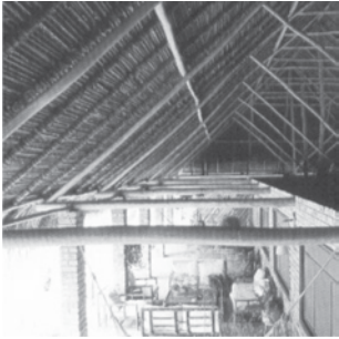
// Armado de la estructura de cubierta
