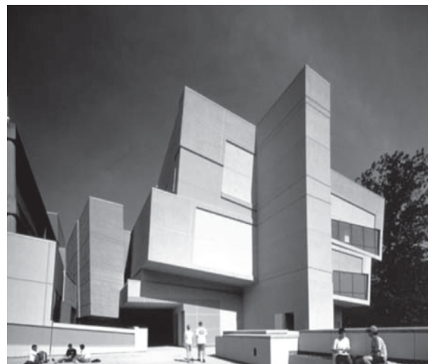
// Aronoff Center for Design and Art, Universidad de Cincinnati. Arquitecto Peter Eisenman,
