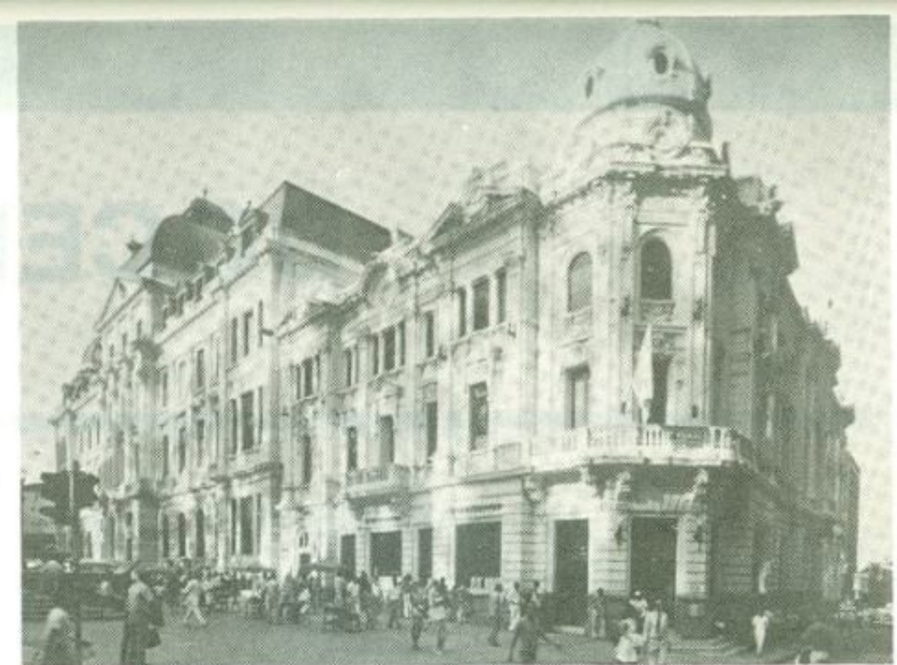
Edificio Otero. Foto: Jorge Mejía.
